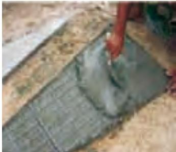
Construcción de las placas de la cubierta. Observe el molde de hierro y la malla de alambre al interior de la mezcla. Al lado, una placa en proceso de secado.
