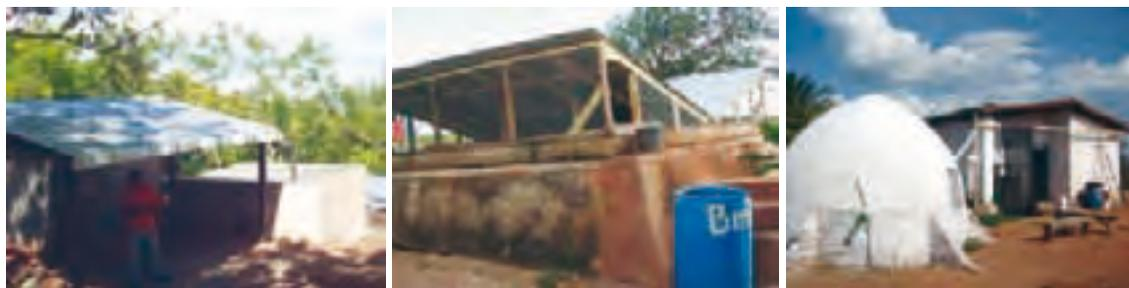
Cisterna cuadrada construida con bloques de cemento rellenos con varillas de hierro y mezcla. La aplicación de una cobertura de mezcla también del lado externo podría reforzar la impermeabilización. Foto: Efraín Rodríguez.
