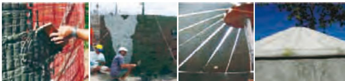
Aplicación del revoque sobre la malla de alambre recubierta por malla fina de polietileno (en este caso, bolsas nuevas y abiertas, de las que se utilizan para comercializar cebolla o papa).
