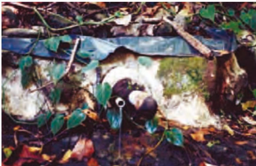
Captación de manantial de caudal crítico (0,5 litros min<sup>-1</sup>), con pequeña presa de mampostería, relleno de piedras para drenaje, cobertura con lámina plástica, protección superior con piedras, tubo para desagüe y conducción. Esta estructura de captación tuvo un costo de USD 20, a precios de 2002. El manantial no estaba en uso por el productor, por ser muy pequeño y casi imperceptible sin la estructura de captación. Foto: Marcos J. Vieira.
