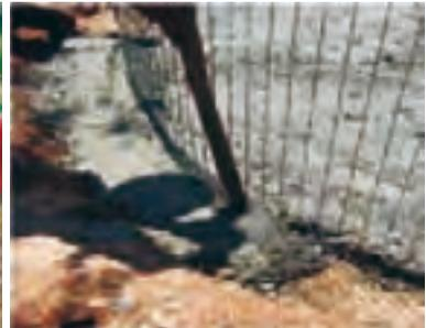
Fijación de la pared de malla de alambre al piso falso.
