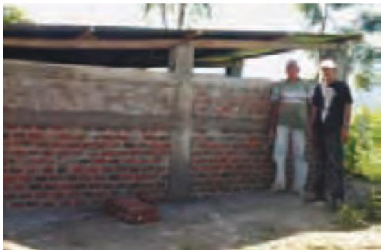
*Estanque rectangular construido con ladrillos y hormigón para almacenamiento de agua derivada de yacimientos y cursos de agua efímeros para uso en riego. El techo puede servir como área de captación. Foto: Gilberto Herrera.*
