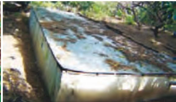
Estanque de hormigón para almacenamiento primario en la captación del yacimiento y derivación para pequeño riego. Note que la tapa evita que la basura contamine el agua y cause problemas de tapo-namiento o contaminación. Foto: José Cristóbal Escobar Betancourt.
