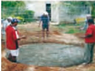
Ubicación de la pared de malla de alambre alrededor del piso falso externo. Observe la excavación y nivelado del terreno, previos a la construcción del piso falso.
